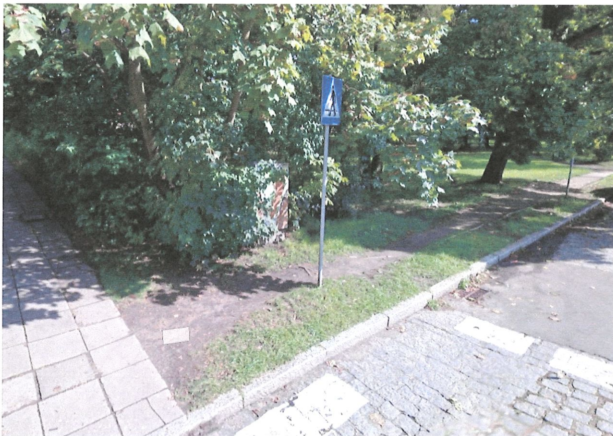
Fot. Zbieg ul. Spółdzielczej i ul. B.Zaleskiego, widoczne oznakowanie pionowe
