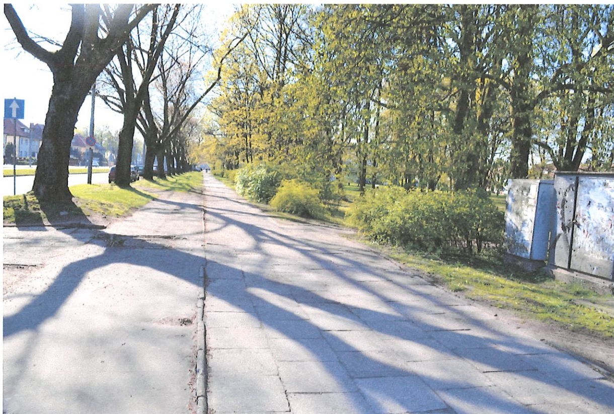
Fot. Chodnik z płyt betonowych od strony ul. Wojska Polskiego
