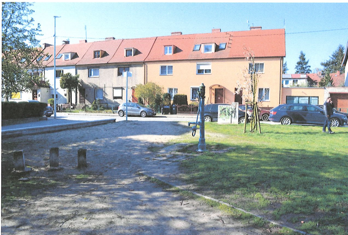
Fot. Widoczne słupki betonowe przeznaczone do rozbiórki
