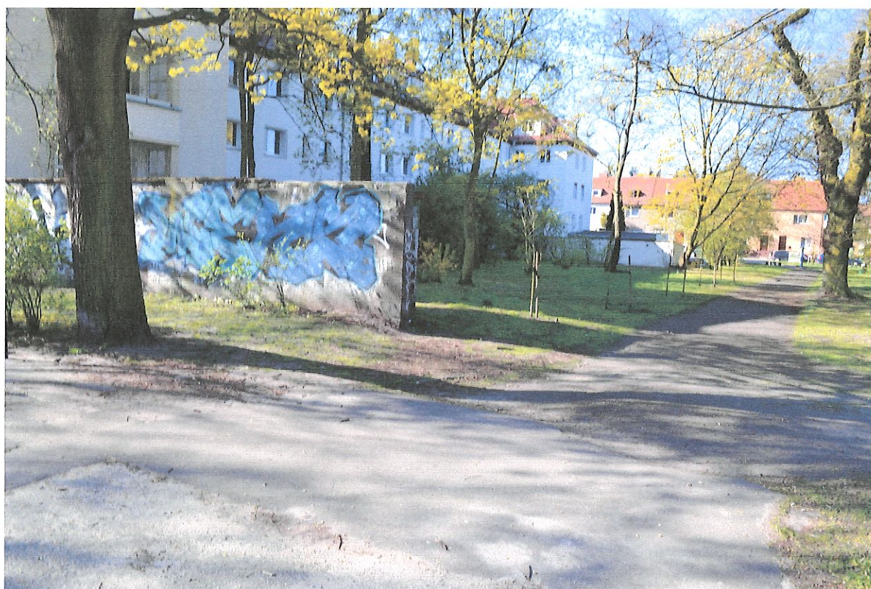
Fot. Widoczny mur betonowy oraz fragment nawierzchni bitumicznej przeznaczone do rozbiórki
