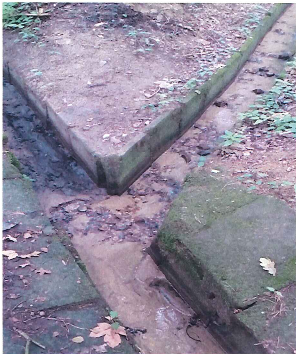
Węzeł Za3 przed deszczem
