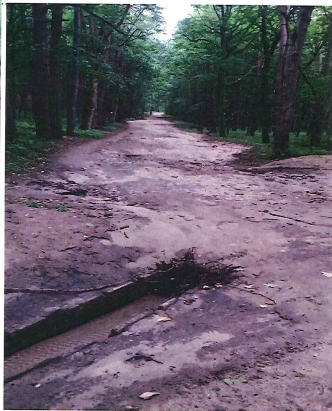
Widok poniżej Za3 na przepust i drogę
