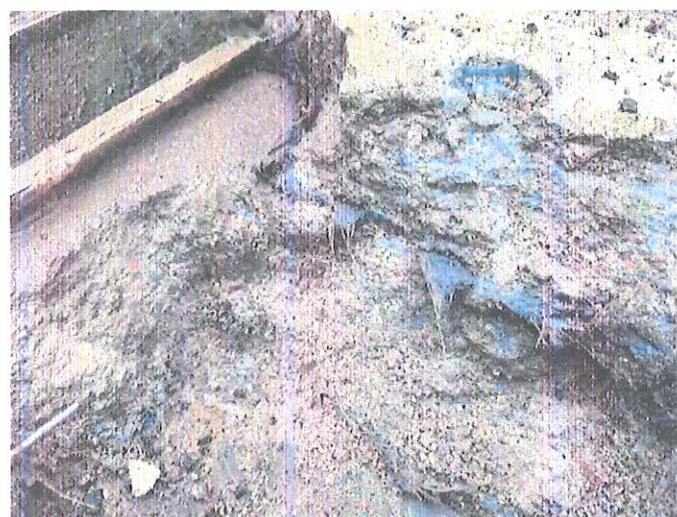
Fot 6. Odkrywka w rejonie korytka odwodnienia.
