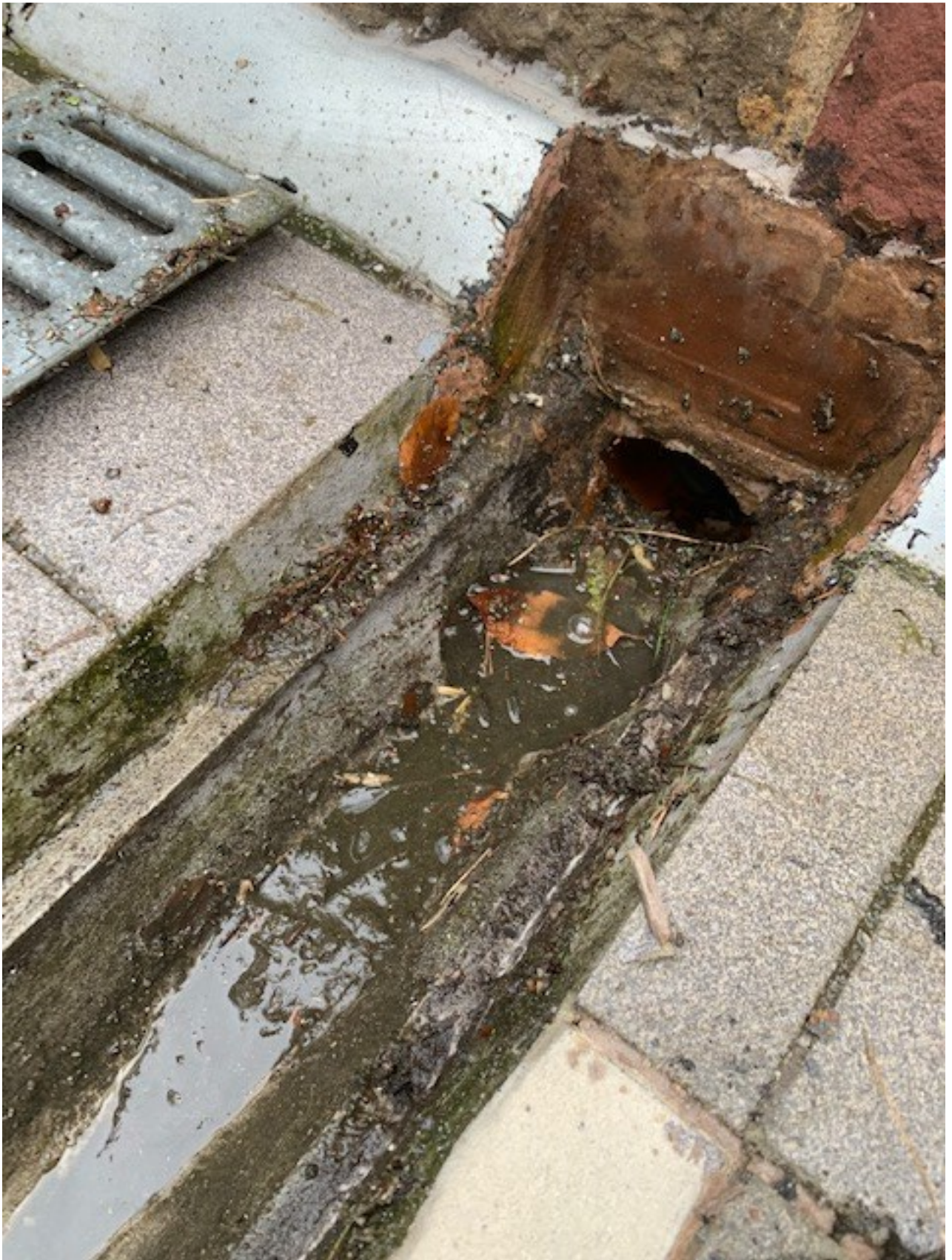
Fot. 7. Widok na odpływ z korytka
