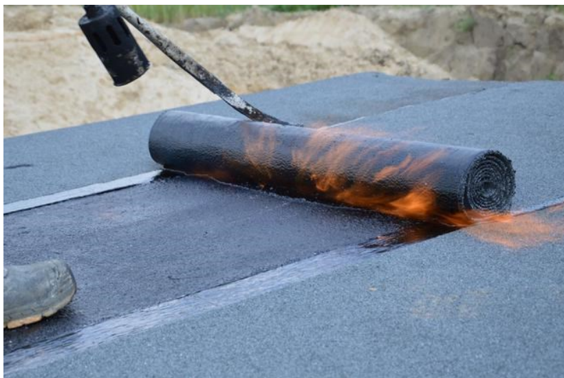
Fot. 9. Sposób ułożenia izolacji przeciwwodnej
