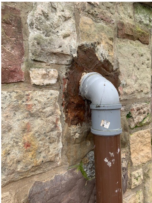
Fot 8. Istniejące odprowadzenie wody.
