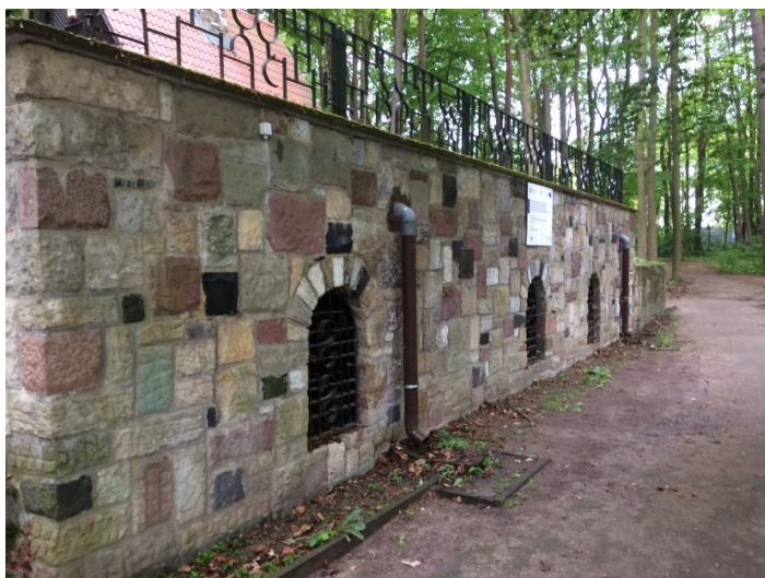
Fot 5. Widok na istniejące odwodnienie tarasu na zewnątrz budynku.
