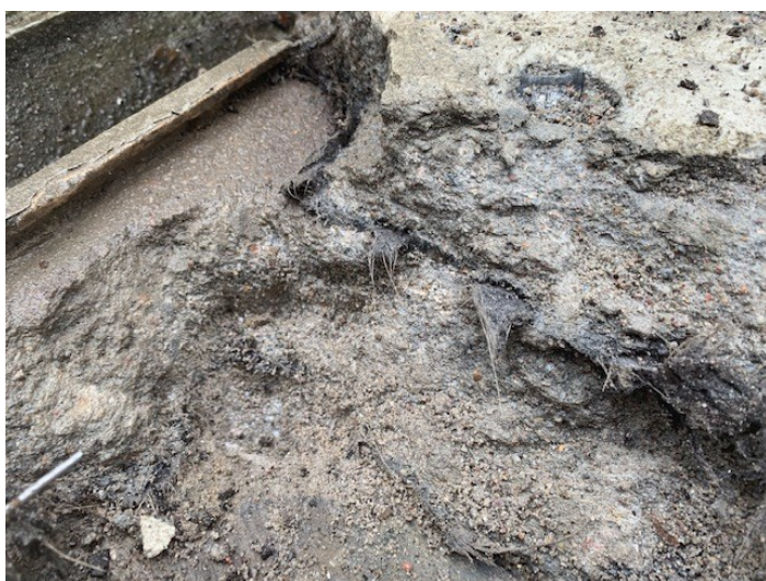
Fot 6. Odkrywka w rejonie korytka odwodnienia.
