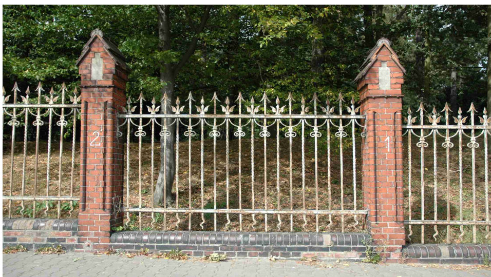
Fot.2 Przęsło drugie – widoczny czarny nalot na ceglach, zanikająca partia granitu pod drugim rzędem cegieł
