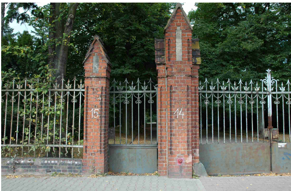
Fot.15 Przęsło 15 Bramka wejściowa – podobnie jak w bramie dolna płycina metalowa do wymiany
