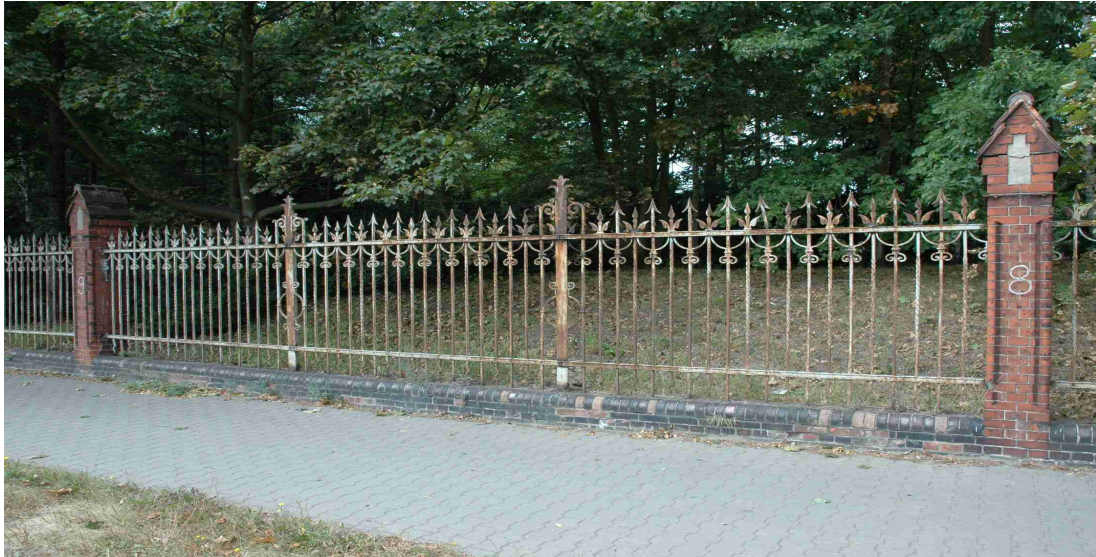
Fot.9 Przęsło dziewiąte. Silna, bardzo czytelna korozja metalu.
