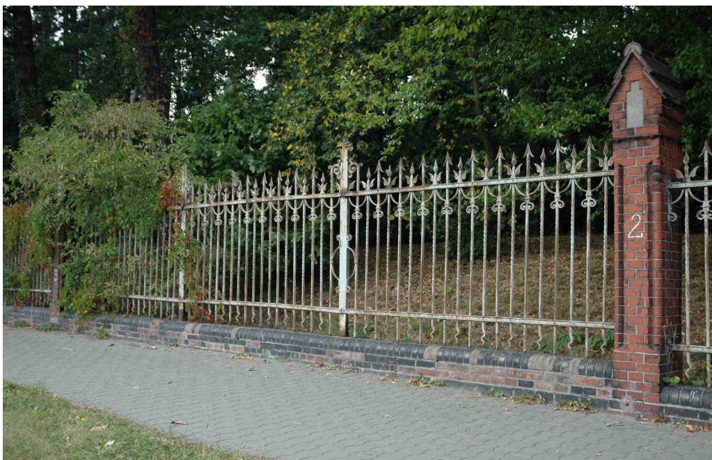
Fot.3 Przęsło trzecie, widoczne jaśniejsze cegły, to wstawki cementowe w partii cokołowej, w elementach metalowych widoczna spod warstwy farby korozja metalu
