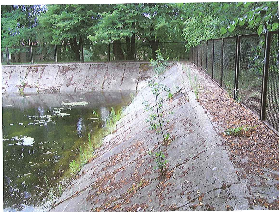
Fot. 5 – Widok krótszej ściany basenu
