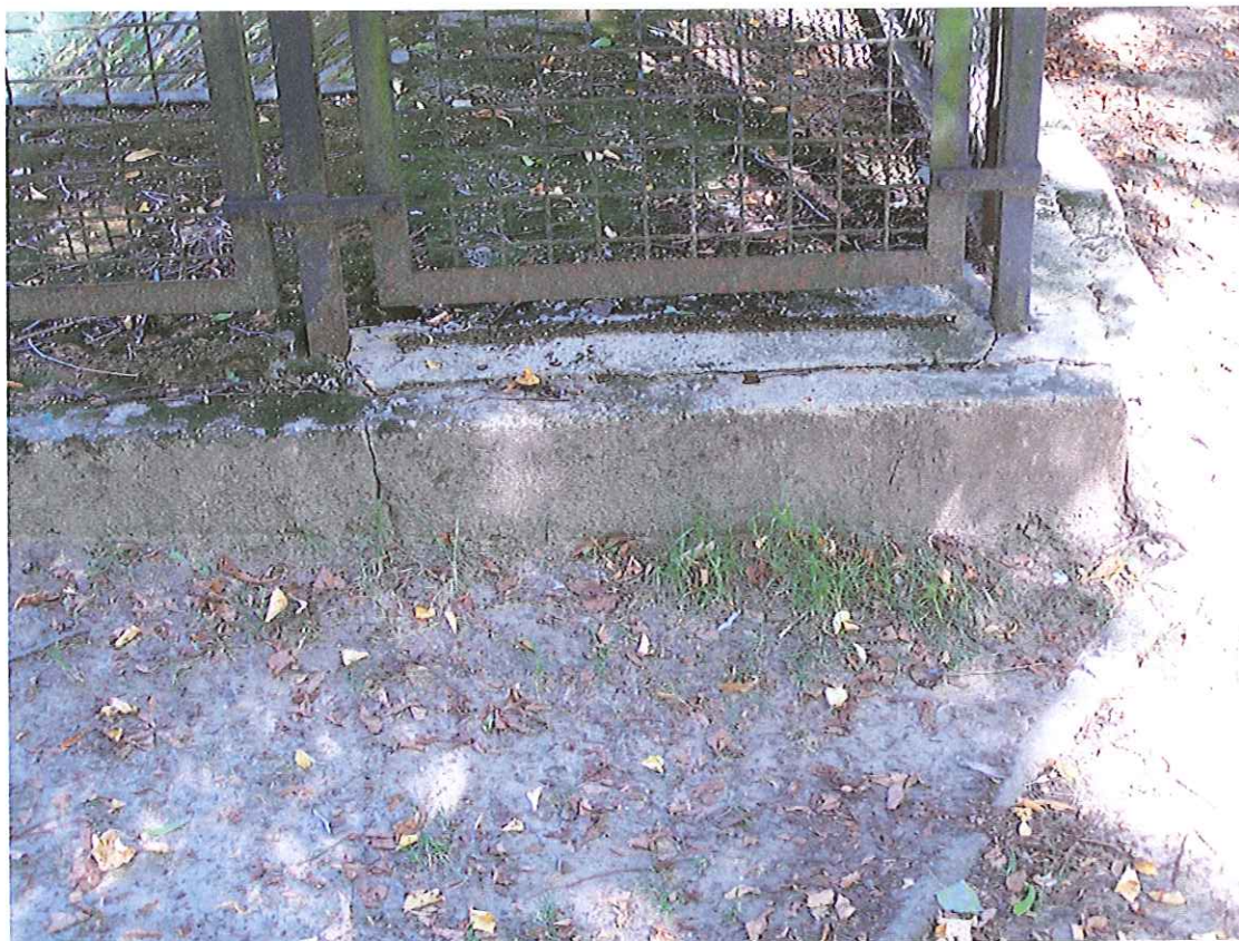
Fot. 11 – Fragment cokołu
