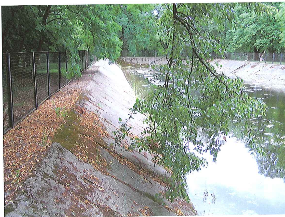
Fot. 6 – Widok dłuższej ściany basenu
