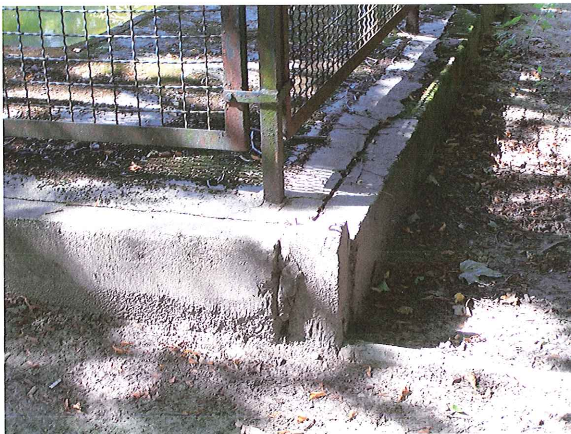
Fot. 12 – Fragment cokołu
