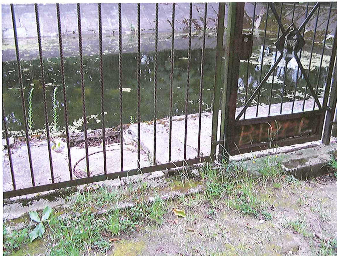
Fot. 9 – Ogrodzenie, przelew górny
