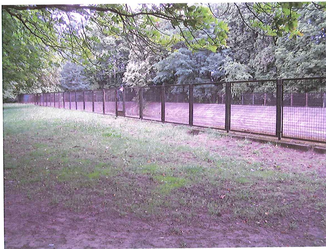
Fot. 8 – Ogrodzenie basenu
