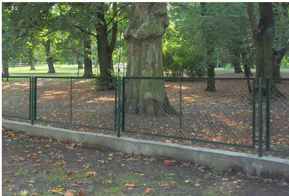
Zdjęcie istniejącego ogrodzenia w miejscu lokalizacji pompowni fontannowej
