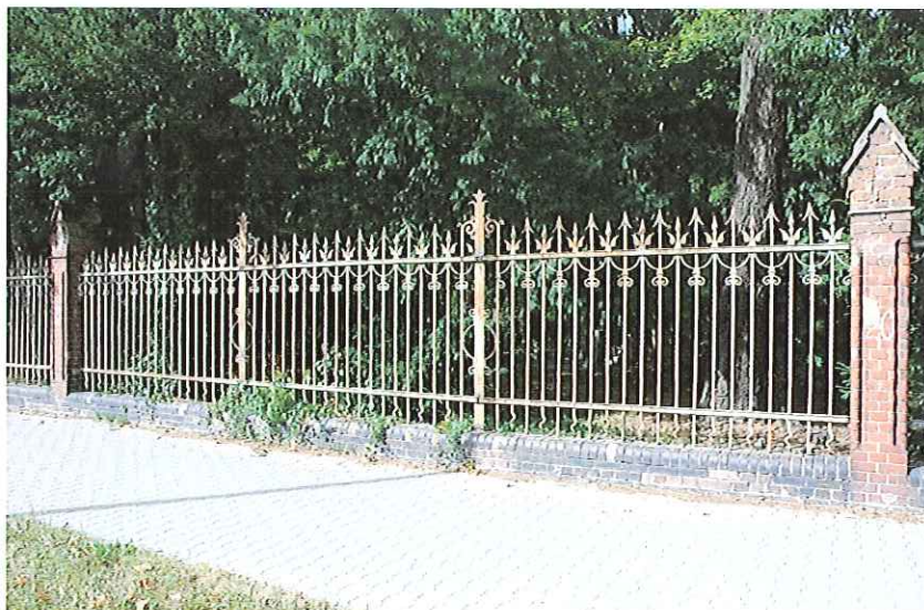
Fot.21 Przęsło 21 – słup nr 20 od połowy do przemurowania
