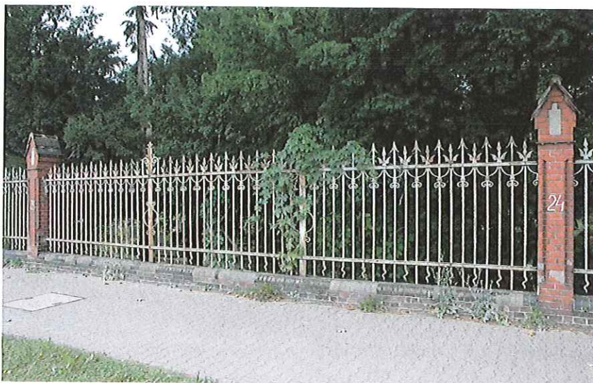
Fot.25 Przęsło 25 – bardzo duża ilość kształtek cokołowych cementowych – do wymiany
