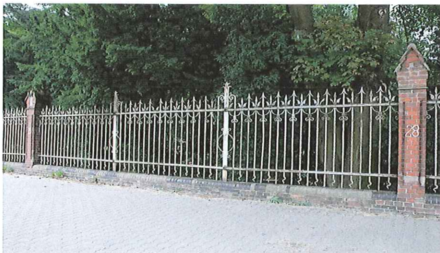
Fot.29 Przęsło 29 – słup 28 w górnej partii do przemurowania na wzór słupa właściwego
