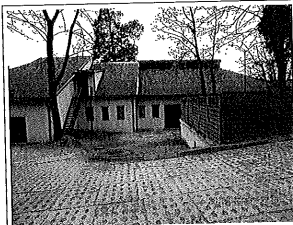
Fot. 5. Ogólny widok przedmiotowego terenu z budynkiem głównym stanowiących przedmioty niniejszego opracowania od strony północnej
