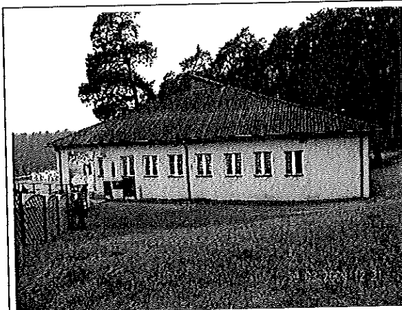
Fot. 3. Ogólny widok przedmiotowego budynku głównego od strony północno-wschodniej będącego przedmiotem niniejszego opracowania
