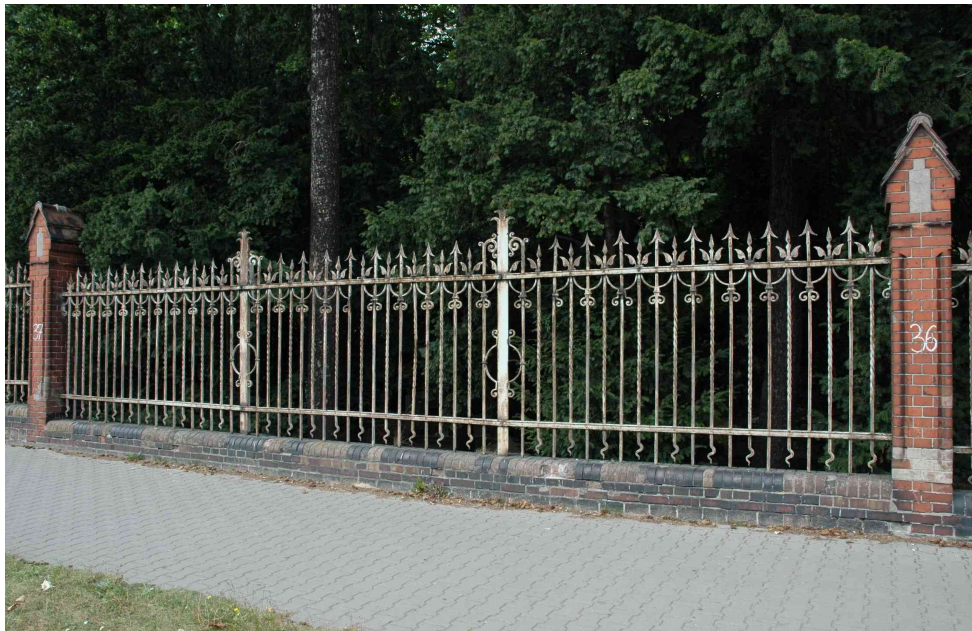
Fot.37 Przęsło 37 – w słupie 36 w dolnej partii kształtki cementowe
