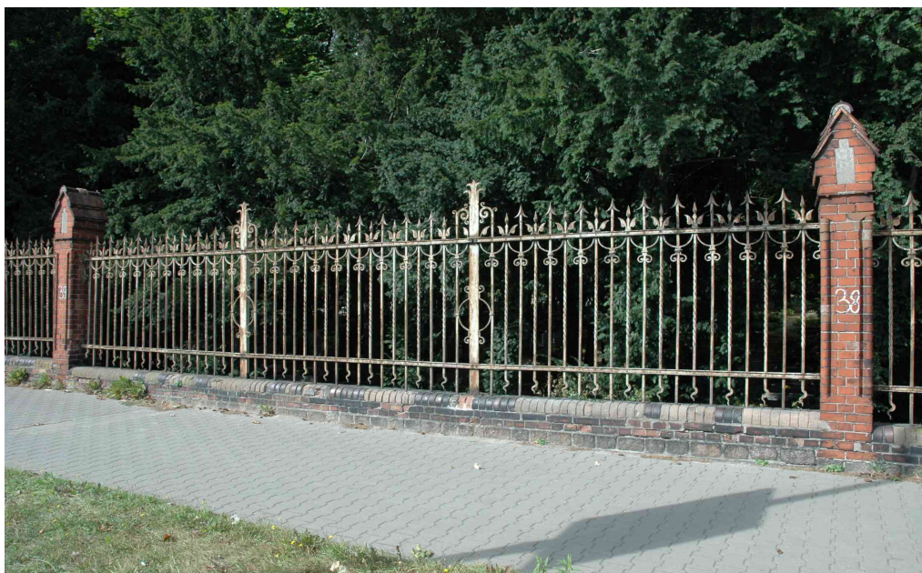
Fot.39 Przęsło 39 – duża ilość kształtek cementowych cokołu do wymiany
