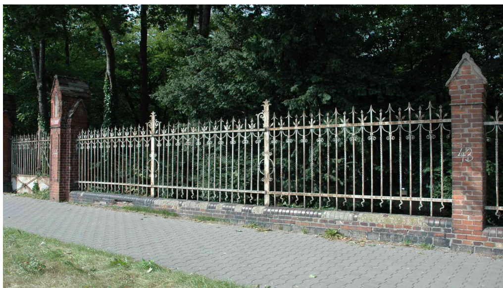
Fot.44 Przęsło 44 – słup 43 cały do wymurowania na wzór starego, oryginalnego słupa
