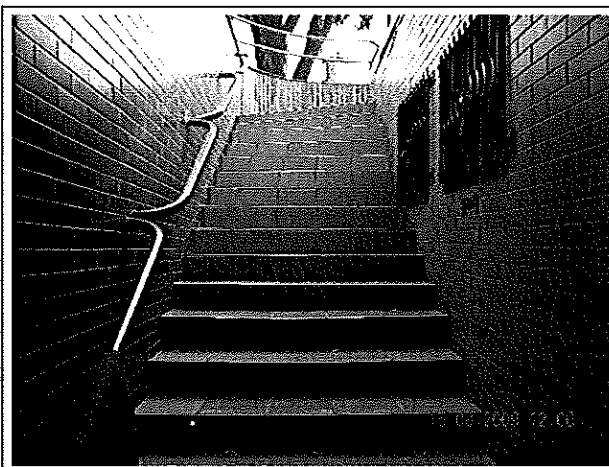
Fot. 4. Widok schodów prowadzących do części męskiej podziemnego szaletu miejskiego ze ścianami oporowymi obłożonymi klinkierowymi płytkami elewacyjnymi
