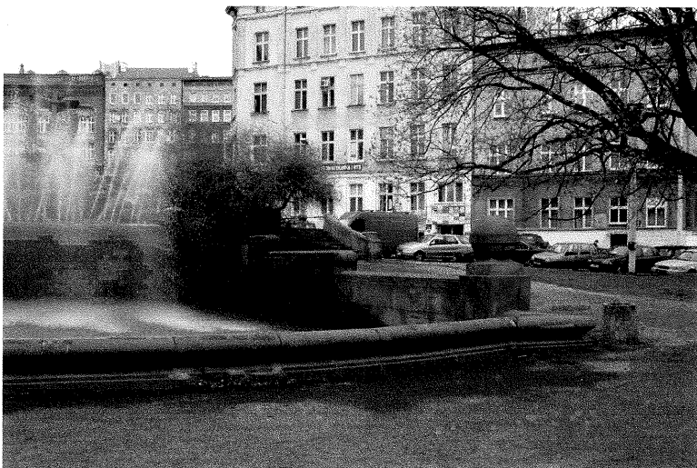
Fot.5 Czoło fontanny z czarnym nalotem atmosferycznym, wyruszeniami i przebarwieniami biologicznymi.
