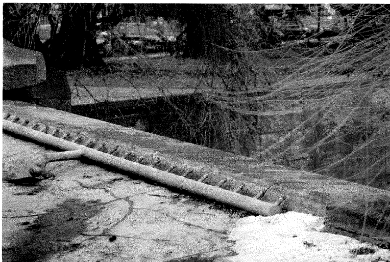
Fot.13 Górne obramienie basenu wykonane z kamienia granitowego
