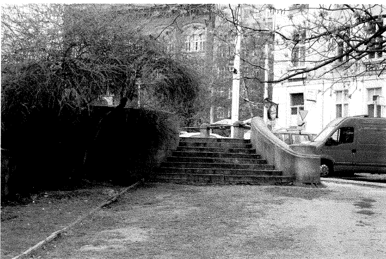
Fot.6 Ozdobne schody granitowe z barierkami granitowymi – z nalotem atmosferycznym, biologicznym.
