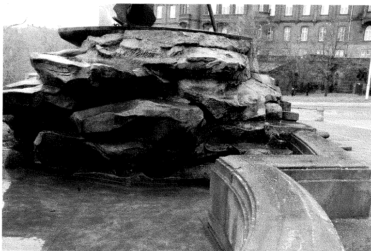
Fot.8 Centralny głaz kotwicą z nalotami biologicznymi, głównie grzybów.
