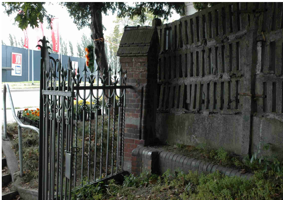
Fot.55 Fragment murku kończącego całe ogrodzenie – słup 54 (nieznakowany), cały do przemurowania
