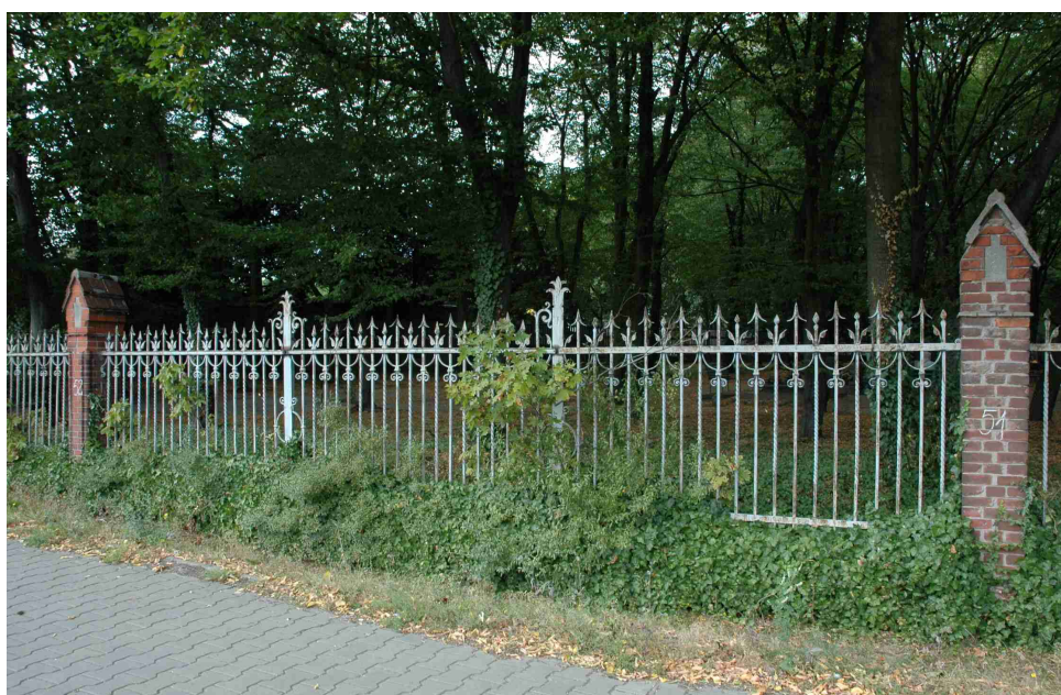
Fot.52 Przęsło 52 – słup 51 cały do wymurowania na wzór starego, oryginalnego słupa
