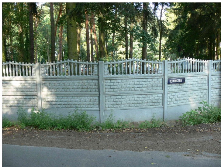
Foto. 5 Wyremontowane ogrodzenie na skrzyżowaniu ul. Ceramicznej i ul. Uczniowskiej - stan po remoncie (wymianie paneli ogrodzeniowych).
