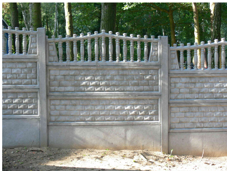
Foto. 2 Przęsło wyremontowane - ogrodzenie betonowe systemowa firmy MICHAŁÓW o wys. 200cm, wzór 9B.
