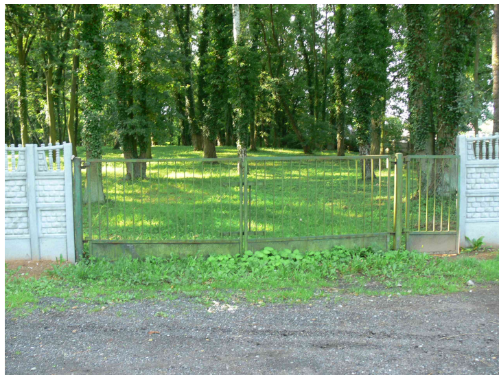
Foto. 4 Brama wjazdowa i furta wejściowa na cmentarz nr 2 - zakończenie wyremontowanego ogrodzenia przy bramie.
