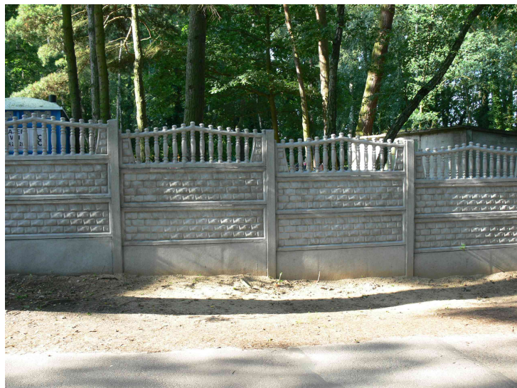
Foto.1 Przęsła wyremontowanej części ogrodzenia. - ogrodzenie betonowe systemowa firmy MICHAŁÓW o wys. 200cm, wzór 9B.
