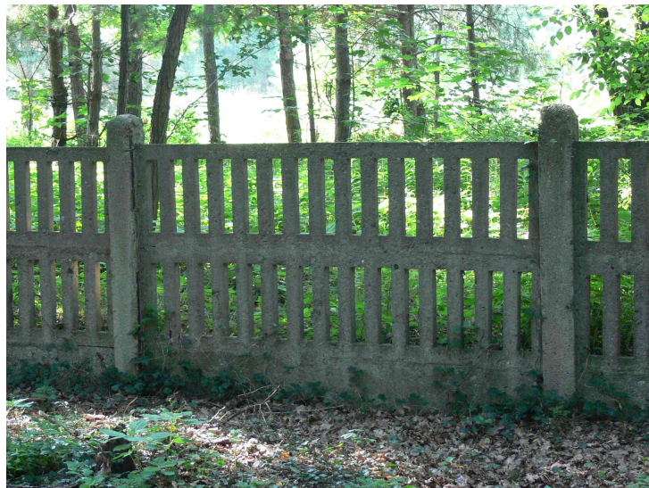
Foto. 6 Istniejące ogrodzenie do remontu - ogrodzenie betonowe o wys. 150cm, panele betonowe ażurowe,
