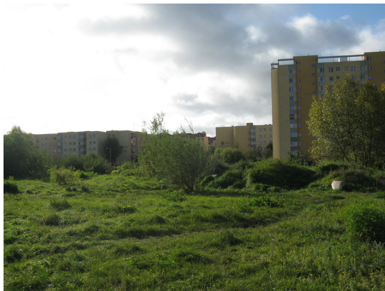
Fot. 6 Widok na nasypy ziemne
